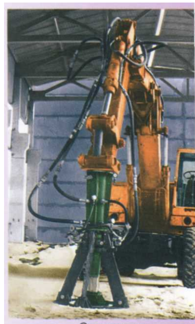
Экскаватор с гидротрамбовкой
