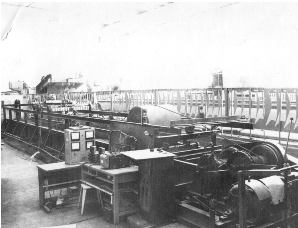
Стенд моделирования резания грунтов 1973 г.
