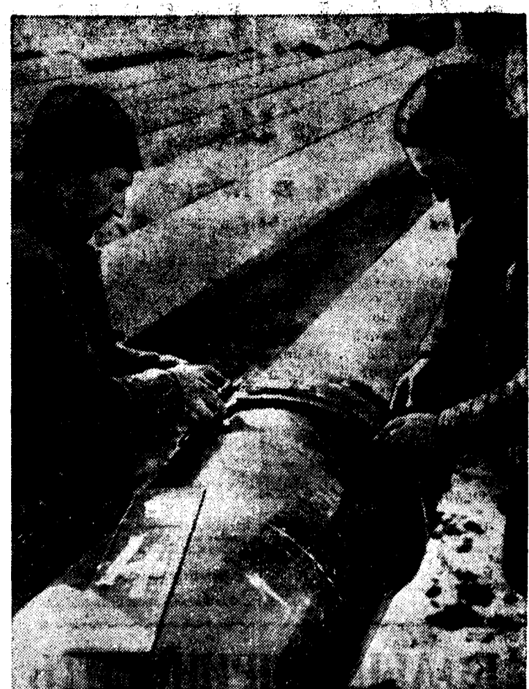
В Польской Народной Республике успешно продолжается строительство нефтепровода Дружба, по которому будет доставляться ценное сырье из далекого Кубышевца-на-Волге. В будущем польские предприятия будут ежегодно перерабатывать 6 миллионов тонн импортной нефти. На снимке: прокладка труб в равине Плонка. Фото Польского центрального фотоагентства.
